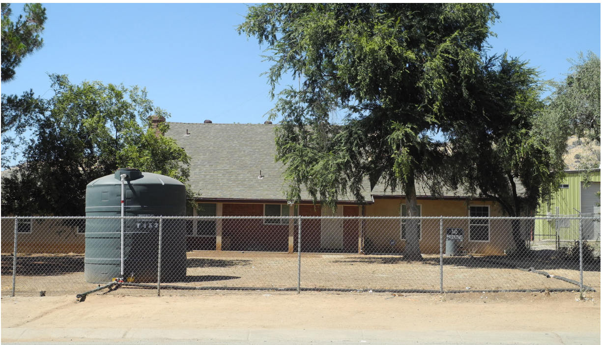
Casa que recibiendo agua de un depósito de agua de emergencia temporal debido a un pozo seco de agua subterránea
